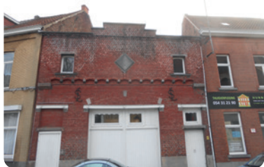
Ninove, Kerkplein - Gasfabriek
