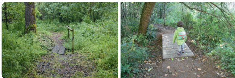
Voor en na vernieuwing van het brugje (Dam Nederhasselt-Aspelare)
