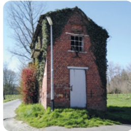
Aspelare, Dam - Duiventil
