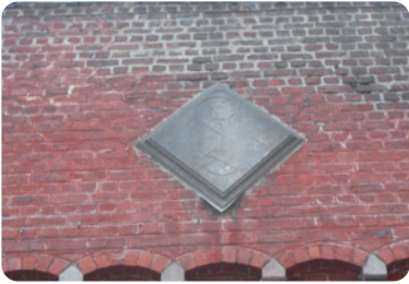
Ninove - Detail gevel gasfabriek Kerkplein
